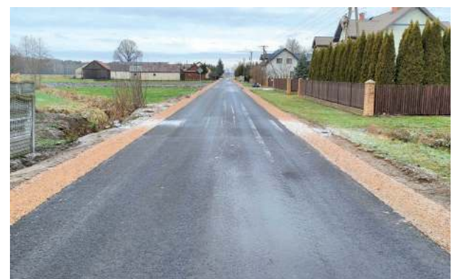
Zmodernizowana droga we wsi Niedźwiadka ma 4,5 m szerokości (fot. Gmina Stanin)
