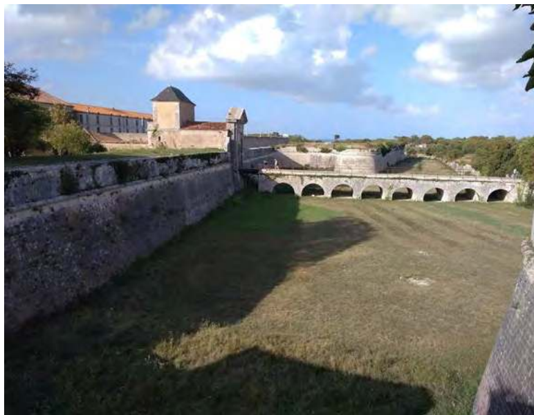
Fragment fortyfikacji cytadeli zaprojektowanej przez Vauban'a (Île de Ré), w których przetrzymywano bagnardów przed zejściem
