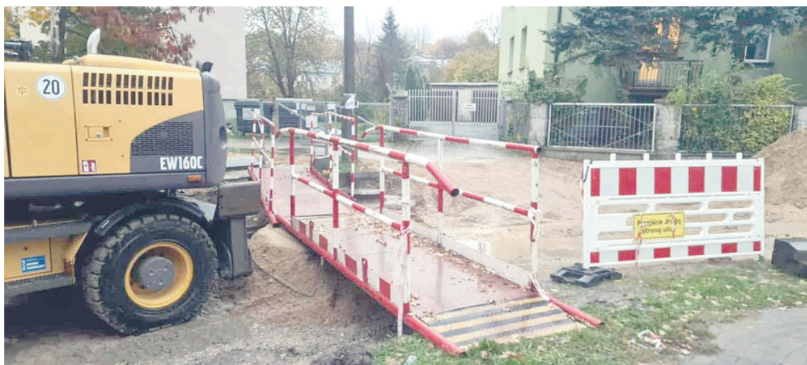
Pod koniec deszczowego dnia 24 października na ulicy od strony budynku urzędu gminy stanęła kładka.
