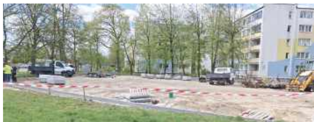
Na skrzyżowaniu ul. Lubelskiej i Norwida praca wre. Budowa parkingu z 56 miejscami ma zakończyć się w czerwcu.
