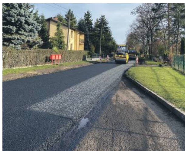
Remont drogi powiatowej w Trześni
