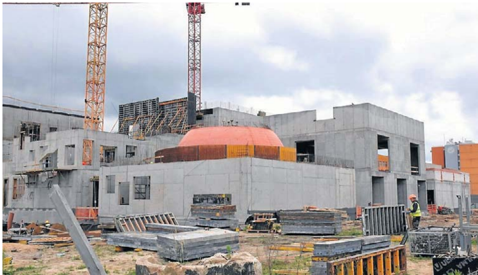
Aktualnie wykonawca prowadzi intensywne roboty konstrukcyjne i wykończeniowe.
