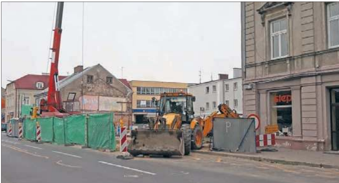
Prace przy ul. Królewieckiej 18
