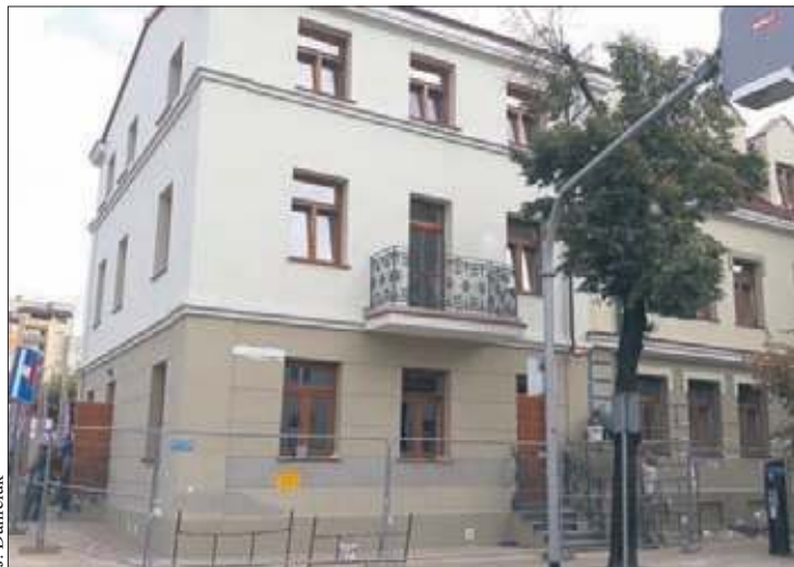
Trwają prace wykończeniowe w budynkach przy ul. Sienkiewicza 40-42
