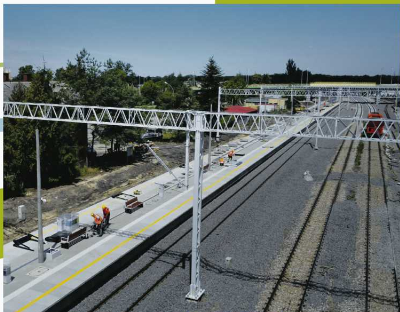
Prace na stacji kolejowej Tarnobrzeg
