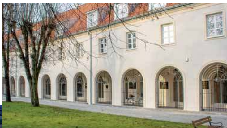
Krzywa Hala po renowacji
