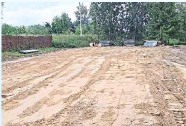
Teren gdzie był stary budynek schroniska, został dosłownie zrównany z ziemią
