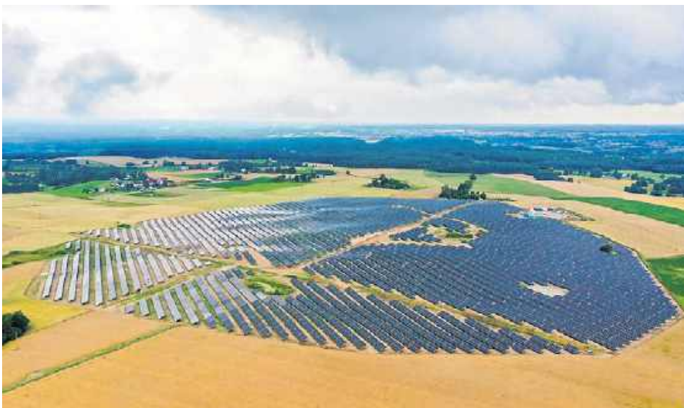
Powstająca na Pomorzu farma fotowoltaiczna PV Łosienice
