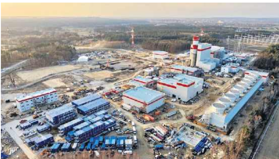
CCGT Grudziądz I w budowie. Podobnie będzie wyglądać CCGT Gdańsk
