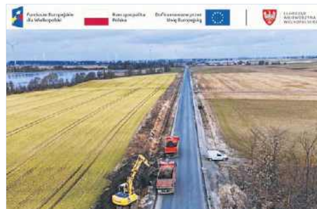
Trwa drugi etap rozbudowy drogi wojewódzkiej na odcinku Margonin - Durowo.
