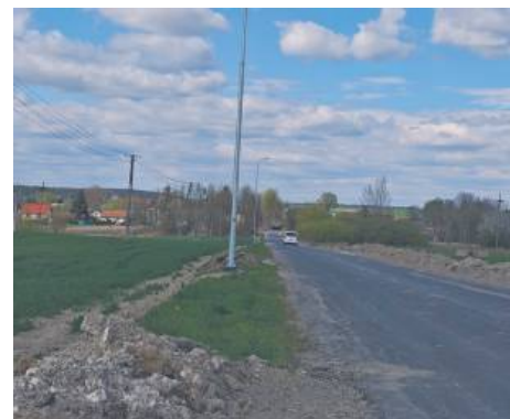
Wola Siennicka - modernizacja oświetlenia ulicznego.
