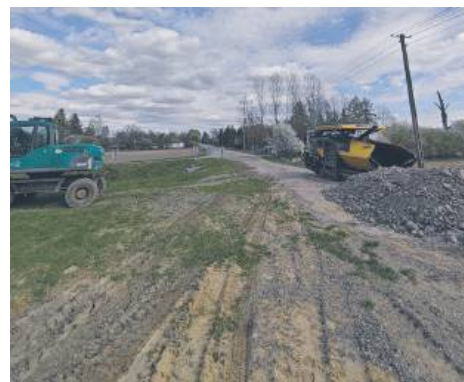
Wola Siennicka - przebudowa drogi -
