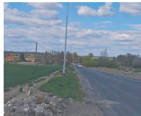
Wola Siennicka - modernizacja oświetlenia ulicznego.
