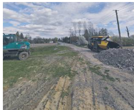
Wola Siennicka - przebudowa drogi -
