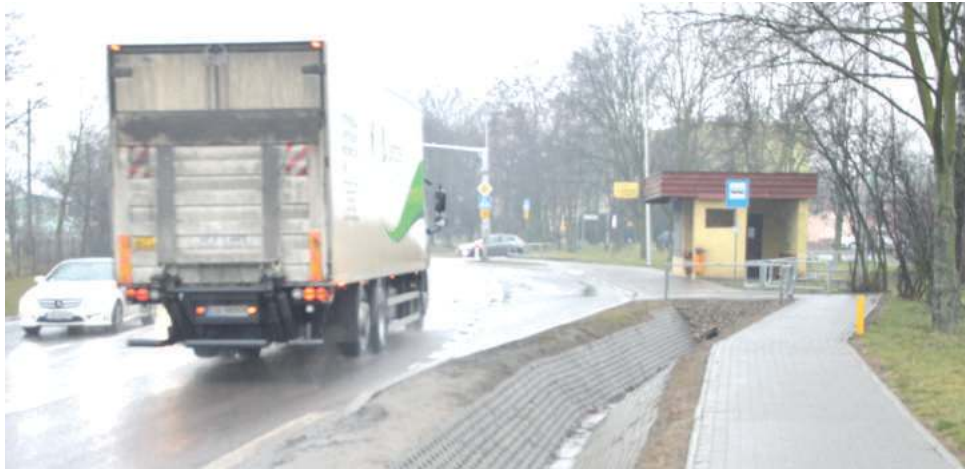
Tuż przy chodniku znajduje się bardzo stromy spadek do rowu wyłożonego betonowymi płytami ażurowymi. O wypadek tu nietrudno, szczególnie po zmroku
