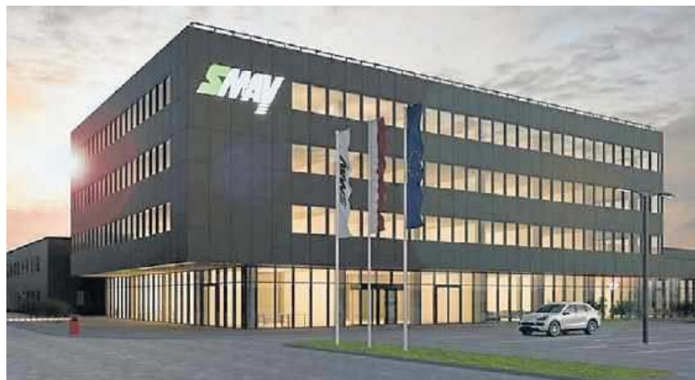
Tak będzie wyglądać siedziba polskiej, rodzinnej firmy SMAY budowana w Podłężu, w Niepołomickiej Strefie Inwestycyjnej. W połowie czerwca wmurowano symboliczny kamień węgielny pod nowy zakład. Łączna wartość inwestycji przekroczy 82 milionów złotych. Powstaną nowe miejsca pracy.
