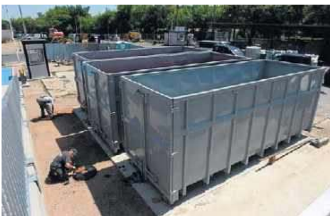
Nowy gminny Punkt Selektywnej Zbiórki Odpadów Komunalnych w Wieliczce jest już prawie gotowy. Otwarcie nastąpi we wrześniu
