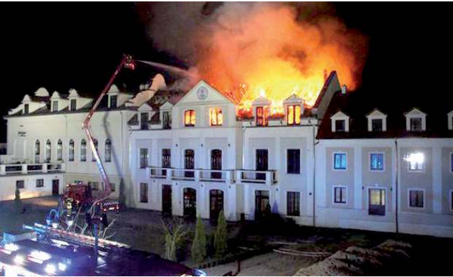
Ubiegłoroczny pożar strawił część kompleksu Domu Pielgrzyma w Kodniu: poddasze oraz najwyższe piętro, na którym znajdowały się pokoje gościnne. Zakonnicy stracili blisko 30 miejsc noclegowych
