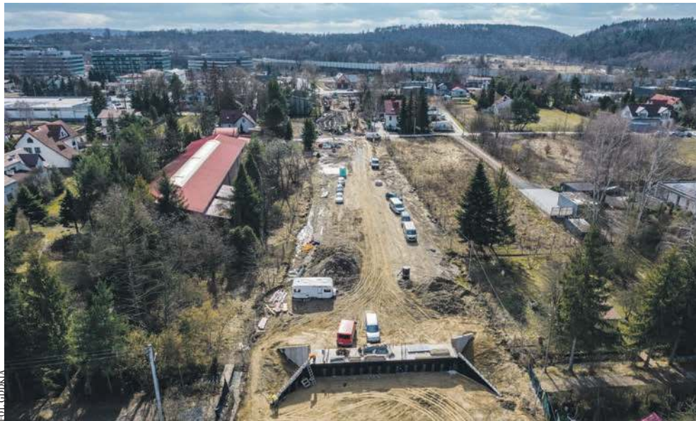
Trwają prace przy budowie obwodnicy Zabierzowa
