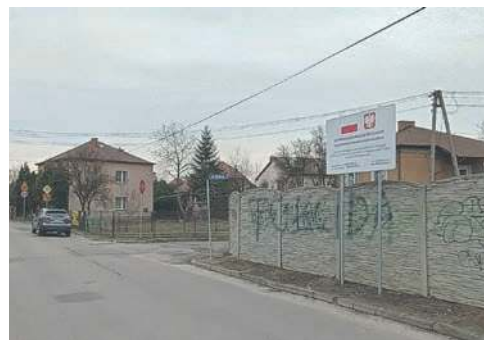
Remontowany ma być 200-metrowy odcinek ulicy Struga
