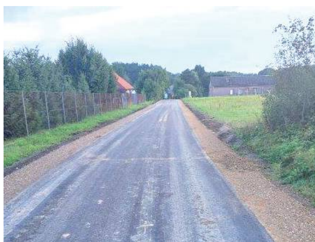
Mieszkańcy korzystają już z nowej drogi. Inwestycja pochłonęła ponad milion złotych. Trwają prace przy kolejnych odcinkach na terenie gminy
