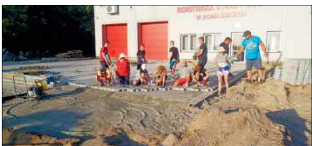
– Starą kostkę zerwaliśmy i daliśmy ją pod spód, żeby bardziej utwardzić powierzchnię – tłumaczy sołtys, Iwona Zieniuk.
