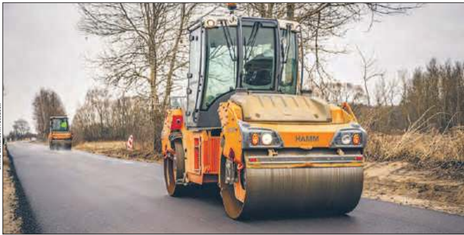
Dzięki realizacji inwestycji, na terenie gminy Łaskarzew powstały 4 km nowej drogi
