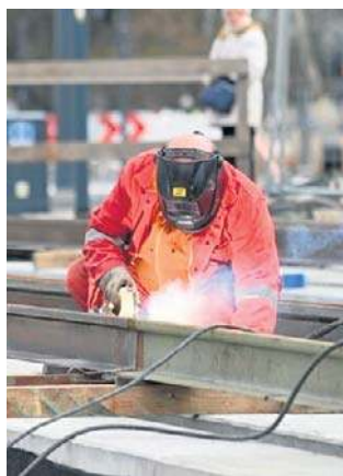
Budowa torowiska na Broniewskiego
