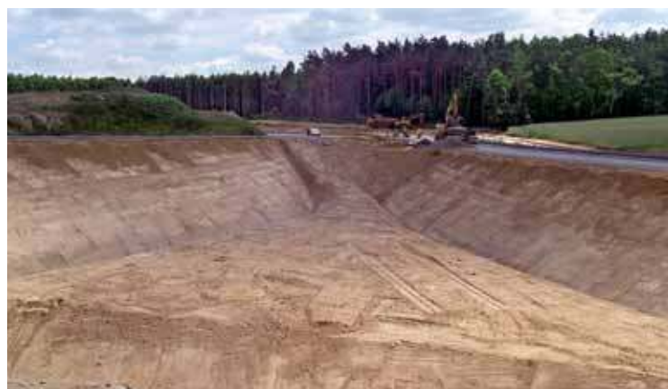
Budowa jednego z wielu zbiorników na wody opadowe
