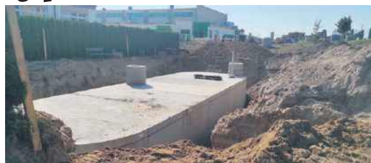
Widok na zbiornik w trakcie realizacji zadania. Fot. UG w Gostycynie
