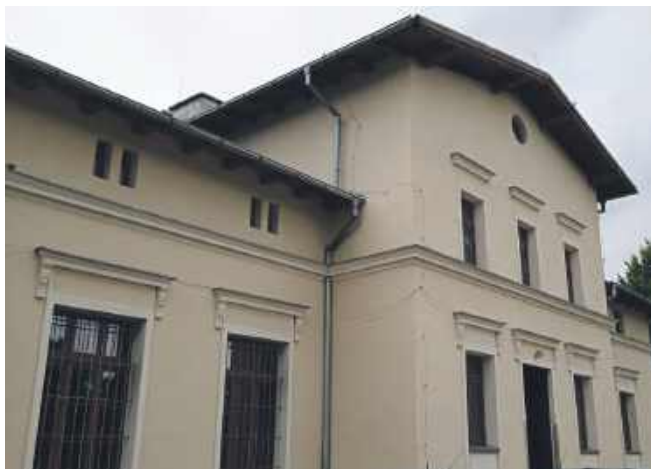
Budynek stacji kolejowej w Skokowej.
