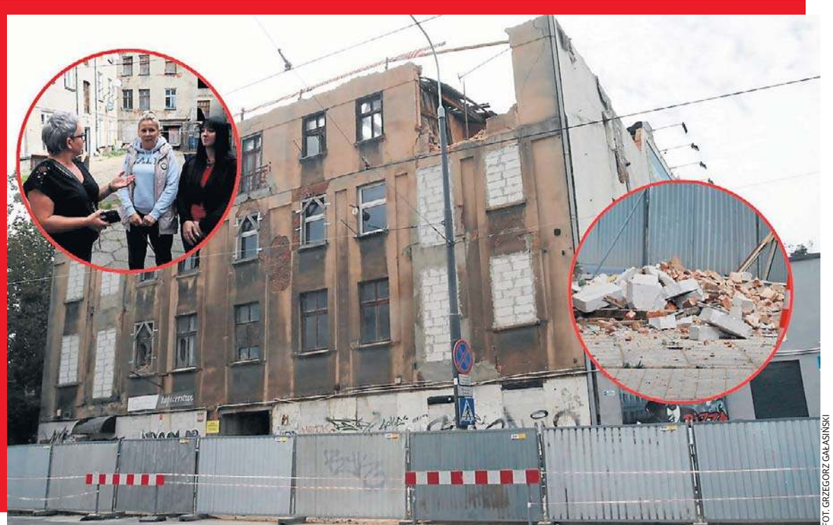
W oficynie przy ul. Zgierskiej 74 ciągle mieszkają ludzie. Rozbiórka frontowego budynku ma się zakończyć 6 listopada.
