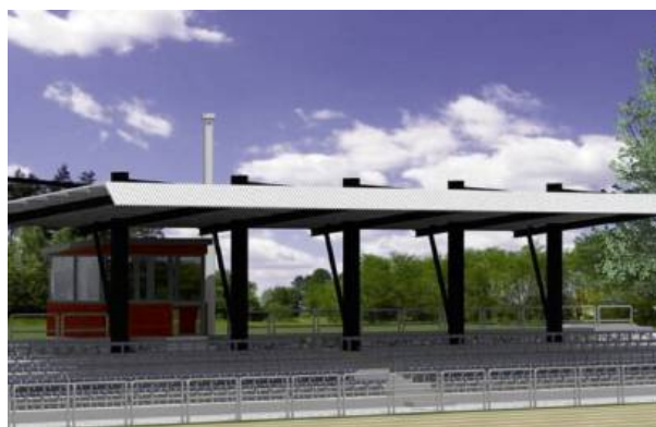
Wizualizacja inwestycji obejmującej m.in. remont bieżni
