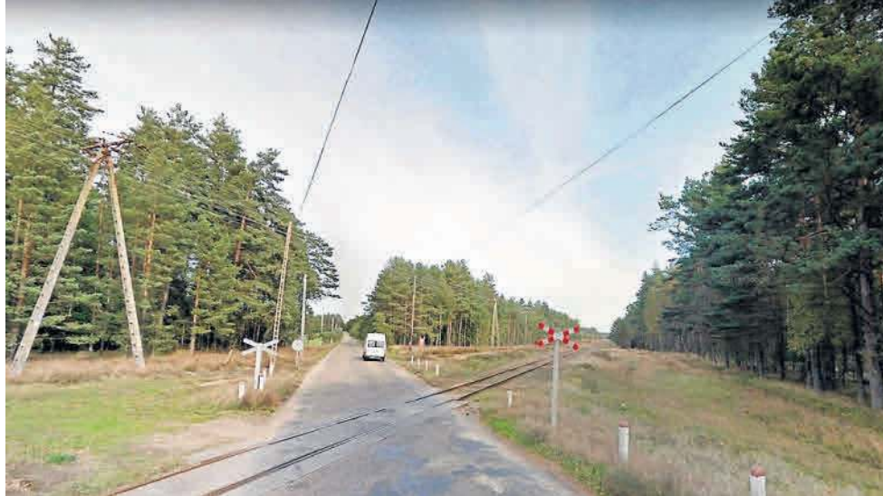
Linia kolejowa nr 212 na odcinku z Lipusza do Bytowa jest okazjonalnie wykorzystywana do przewozów towarowych. Na zdjęciu: przejazd kolejowy w pobliżu Osławy-Dąbrowy
