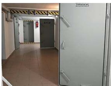
SCHRONY NIEZBYT BEZPIECZNE |7
