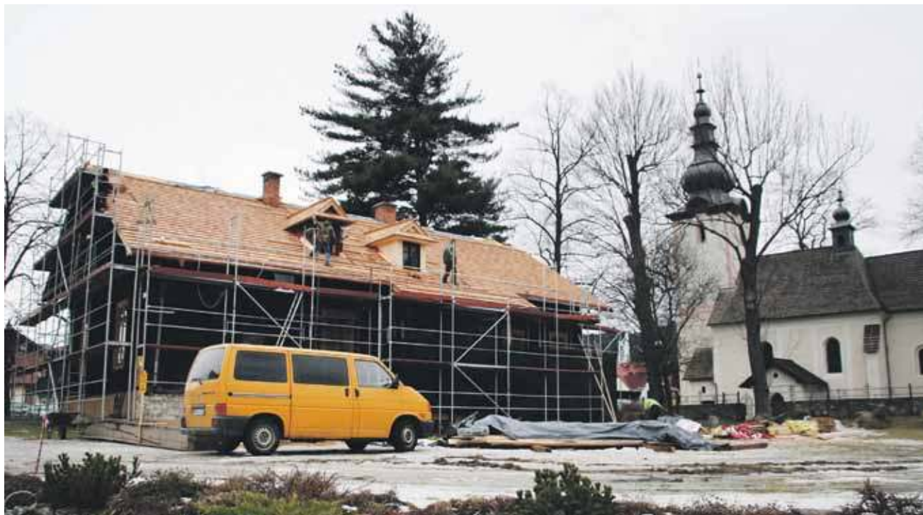
Trwa wymiana dachu na starej plebanii w Krościenku.
