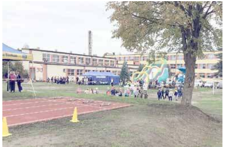
Działaniami renowacyjnymi objęto budynek szkoły i jej otoczenie
