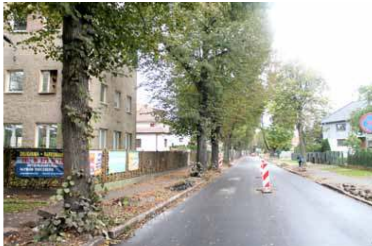
Kierownik Wiesław Bączkowski z ZDP zaznacza, że w trakcie prowadzonych prac nie dochodzi do uszkodzenia korzeni drzew
