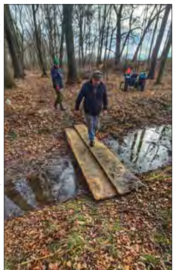
Kładki pozwalają znów na bezpieczne spacerowanie po parku.
