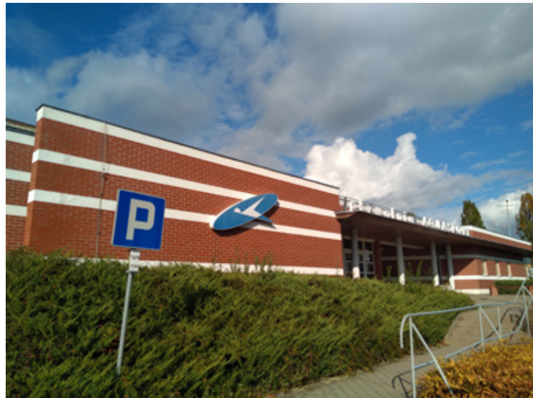
To właśnie budynek pływalni Aquasport w Brzegu Dolnym zostanie zmodernizowany za kwotę 9,5 mln złotych.
