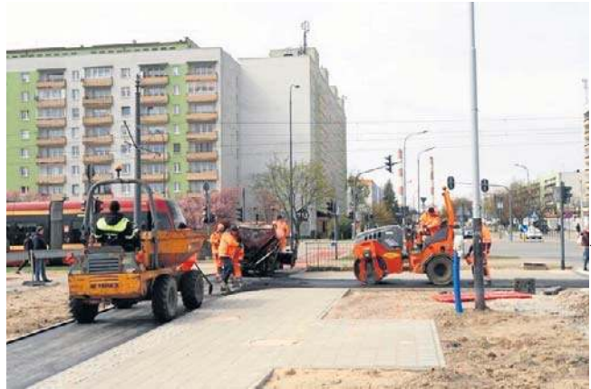
Intensywne prace trwają na ulicy Zakładowej. Pracują, aż miło popatrzeć
