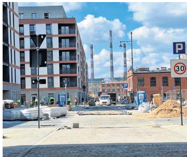
Budowa nowej ulicy przez Ogrody Geyera jest na absolutnym finiszu
