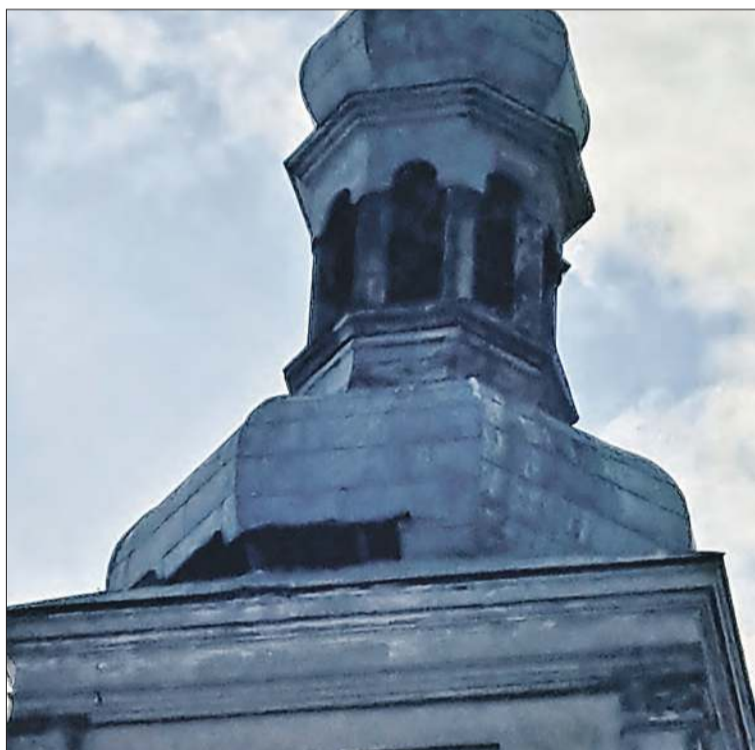
Z wieży znikają kolejne fragmenty blachy
