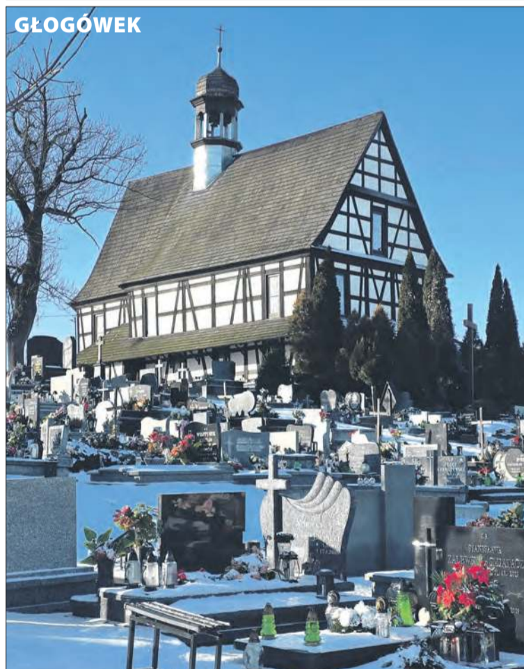
Kościół pw. Świętego Krzyża w Głogówku w zimowej scenarii. Zbudowana w 1705 r. świątynia jest jedną z niewielu budowli o konstrukcji szachulcowej na ziemi prudnickiej.
