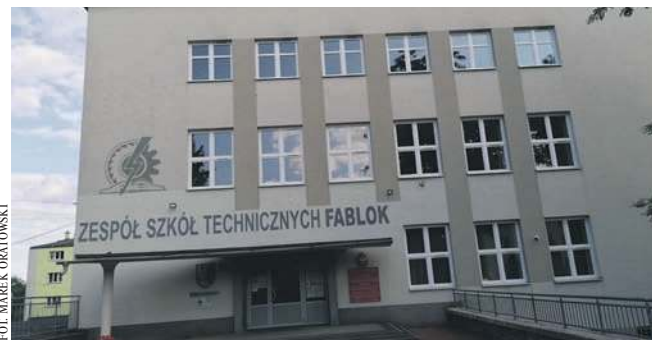
W tym roku rozpocznie się budowa boiska wielofunkcyjnego przy Zespole Szkół Technicznych Fablok w Chrzanowie. Inwestycja będzie dwuletnia
