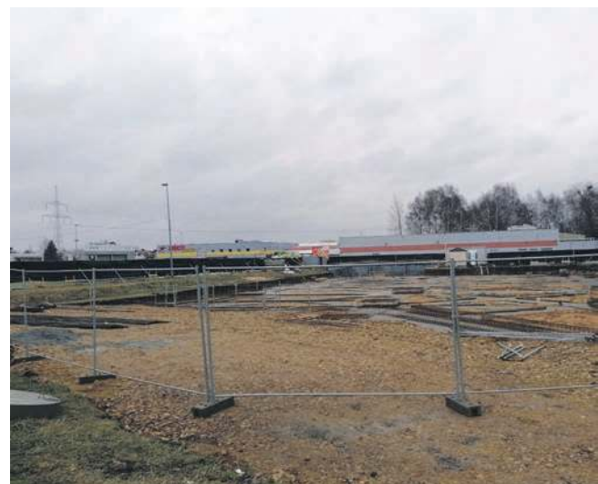
Prace budowlane trwają od ponad miesiąca
