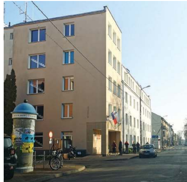
W kwietniu br. może rozpocząć się remont w budynku Urzędu Miasta
