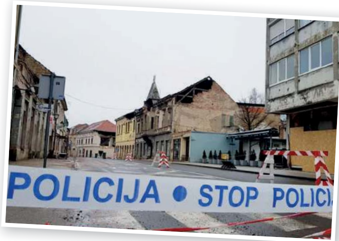
W wyniku trzęsienia ziemi wiele budynków w Petrinji zawaliło się, wiele zostało również poważnie uszkodzonych
