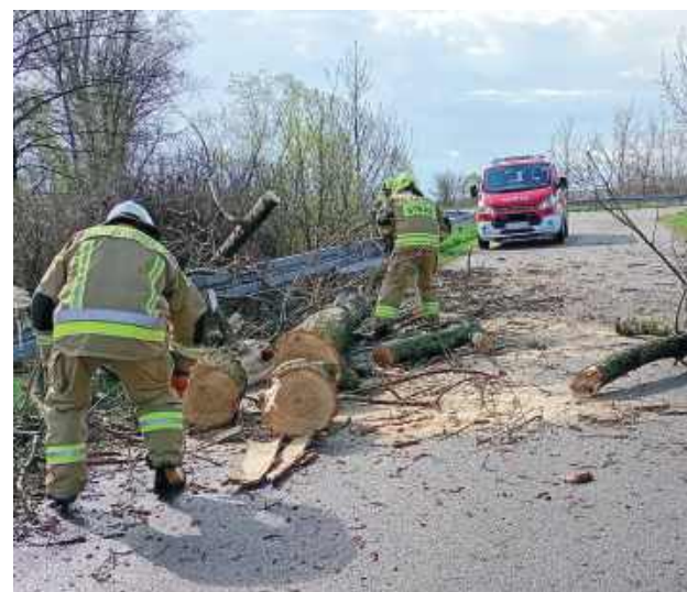
Strażacy pracowali w pocie czoła, by usunąć powalone drzewa z drogi
