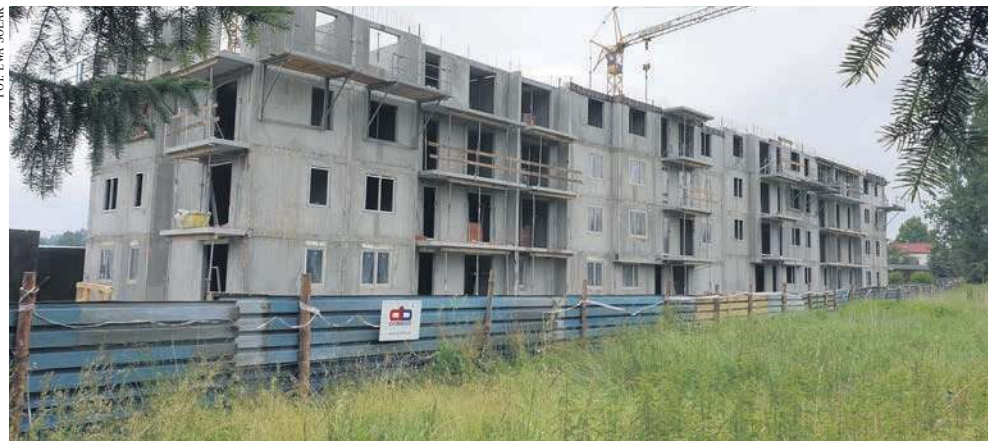
Chrzanów. Jeden z budowanych bloków przy ul. Partyzantów
