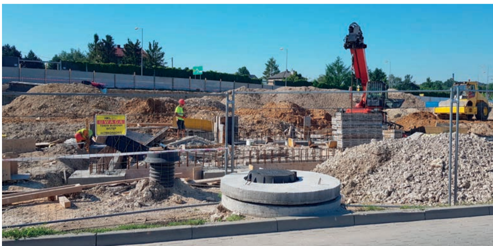
Od kilku tygodni trwają prace ziemne na budowie Castoramy
