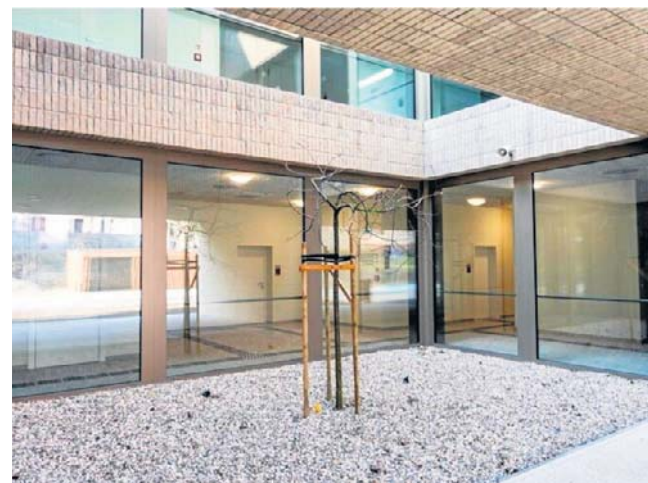
Nowo zbudowane hospicjum w Rybniku-Niedobczycach otrzymało pozwolenie na użytkowanie
