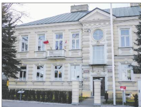
Siedziba władz miasta Garwolin przy ul. Staszica 15 ma ponad 100 lat. Budynek powstał w 1910 roku. Przed wojną mieściło się tu starostwo powiatowe. Dziś działa tu urząd miasta. W 1974 roku obiekt wpisano do rejestru zabytków
