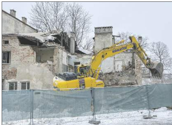
☛ Po rozbiórce w miejscu dawnej gorzelnii ma stanąć warsztat autobusowy
