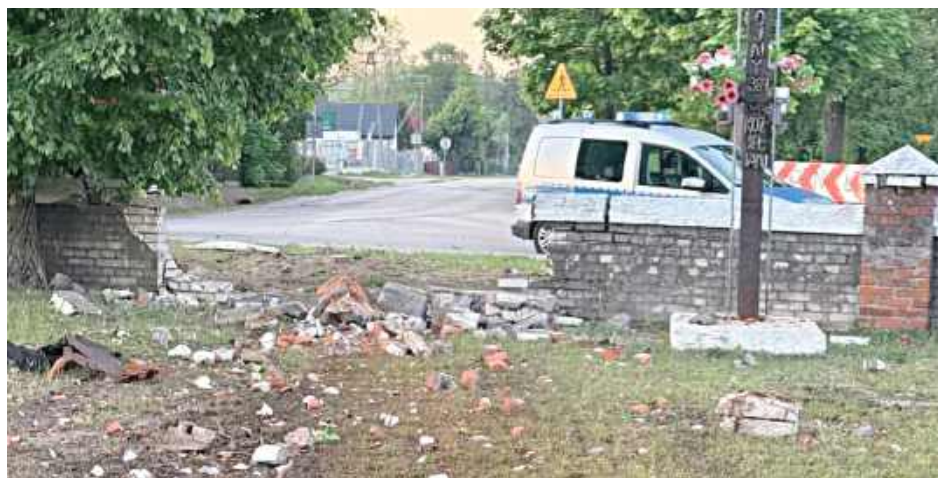
Kierowca rozjechał mur kościoła w Leszkowicach
