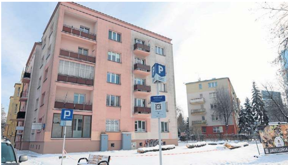
Inwestor przygotowuje się już do rozpoczęcia inwestycji. W miejscu, gdzie rosły drzewa, stanie budynek usługowy. Mieszkańcy bloku są zrozpaczeni
