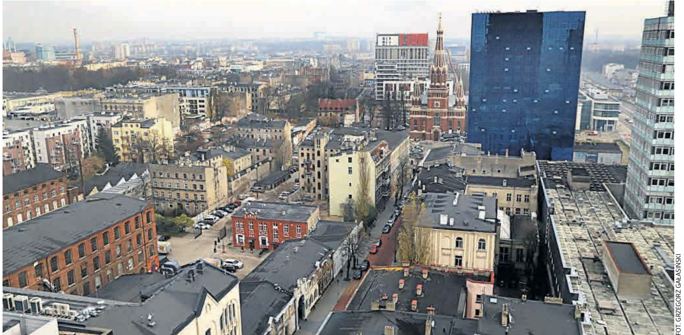
Głównego remontu wymaga 1200 spośród tysięcy łódzkich kamienic, a to kosztuje miliardy
