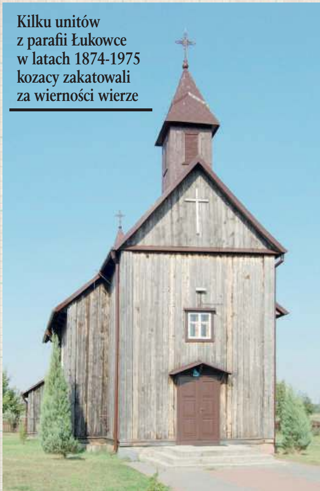
Dawna cerkiewka unicka została zbudowana bez użycia gwoździ, tradycyjną techniką, po 250 latach dalej może być bezpiecznie użytkowana
