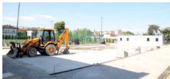
Prace związane z budową lodowiska wykonane zostały już w ponad 60 procentach
