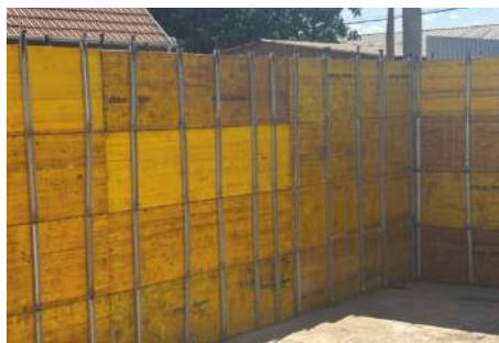
Rys. 4. Deskowanie ścian wykonane z płyt trójwarstwowych, ściąganych za pomocą stalowych pasków krępowanych klinami
