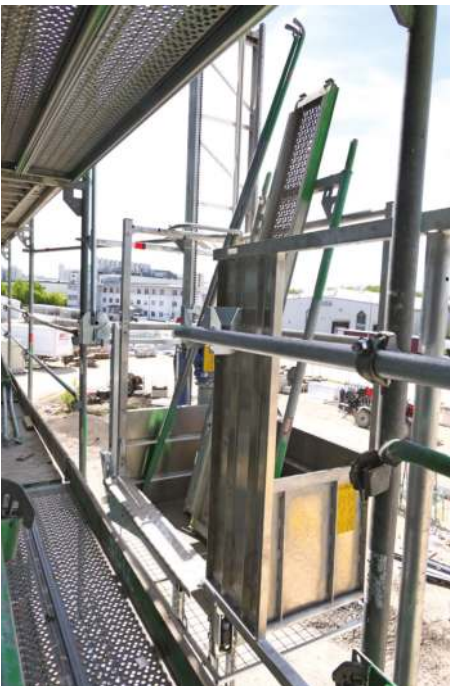
Fot. 7. Bariera zabezpieczenia piętrowego dźwigu GEDA 200 Z Comfort
