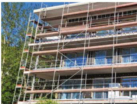
Fot. 3. Rusztowanie niewłaściwie stężone (stężenia nie stanowią układu wieżowego ani wielopłaszczyznowego)
