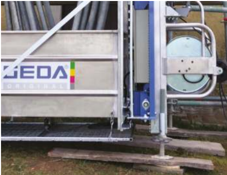
Fot. 6. Ustawienie jednostki podstawowej dźwigu GEDA 200 Z Comfort za pomocą podstawek śrubowych
