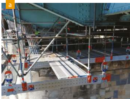
Fot. 2. Podwieszenie rusztowania modułowego na systemowych belkach aluminiowych Layher FlexBeam:
