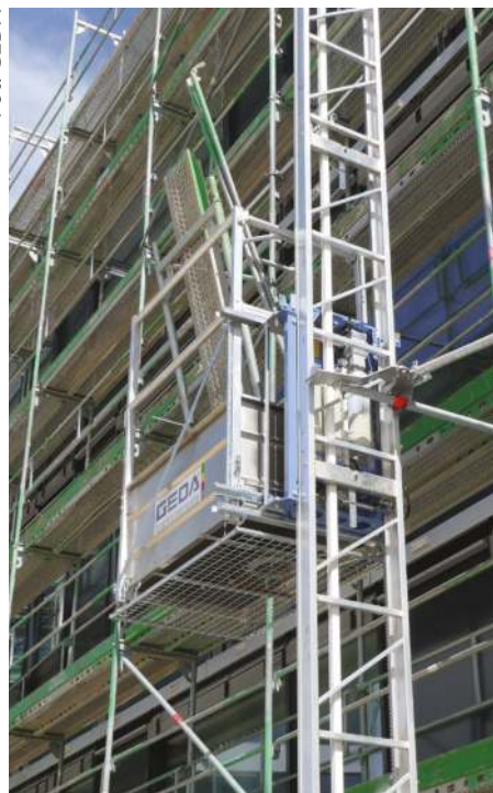
Fot. 3. Modułowy system kotwień dźwigu GEDA 200 Z Comfort
