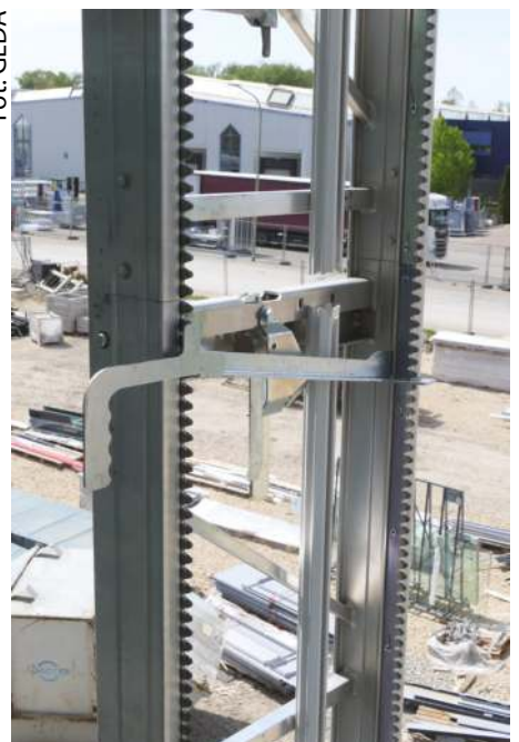
Fot. 4. Szyna zatrzymania na piętrze, zastosowana w dźwigu GEDA 200 Z Comfort
