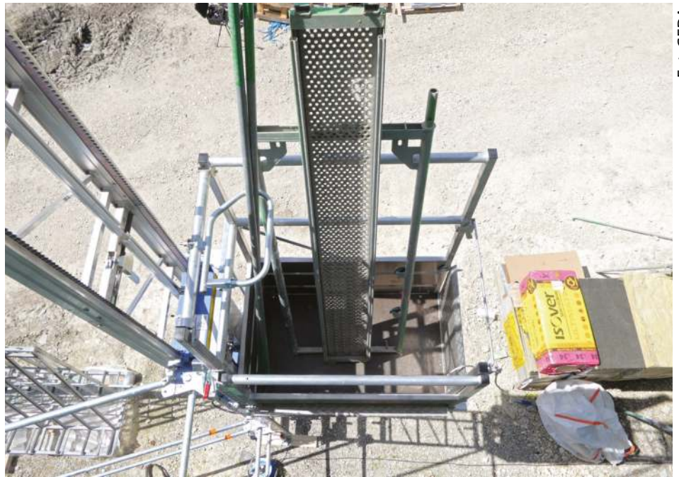
Fot. 8. Przesuwna do rozładunku platforma dźwigu GEDA 200 Z Comfort
