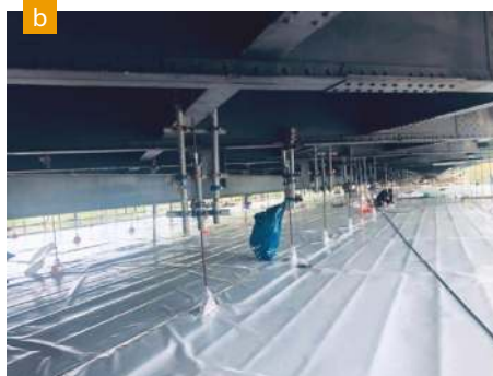
Fot. 2. Podwieszenie rusztowania modułowego na systemowych belkach aluminiowych Layher FlexBeam:
