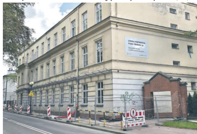
W zabytkowym budynku „Elektryka” prace obejmują m.in. elewację, na której zachowane zostaną charakterystyczne detale architektoniczne.
