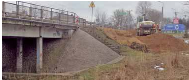
Aktualnie trwa budowa mostu tymczasowego
