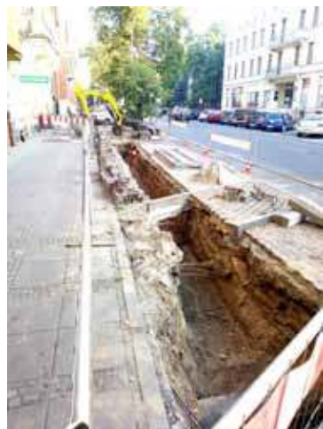
Roboty związane są z wykonaniem przyłącza ciepłego w technologii rur preizolowanych
